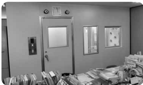
室外からエアシャワーの様子が見学できる窓付きです
