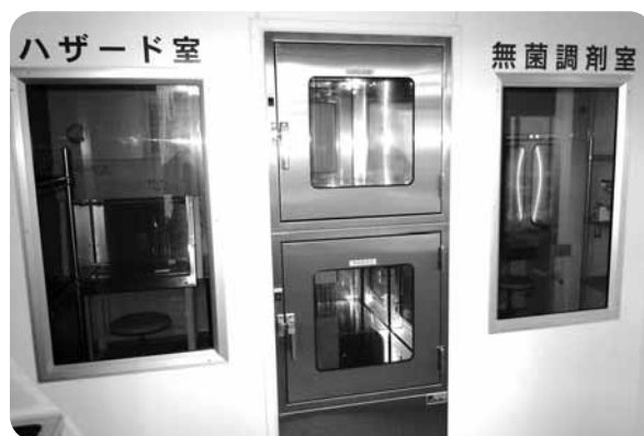
無菌調剤室とハザード室の間にパスボックスを設置。2段で3方向型の特殊です！（前室側から撮影）
